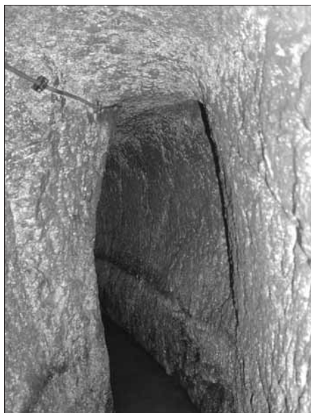
Slavonice. Chodba obdelníkového profilu pod náměstím.
