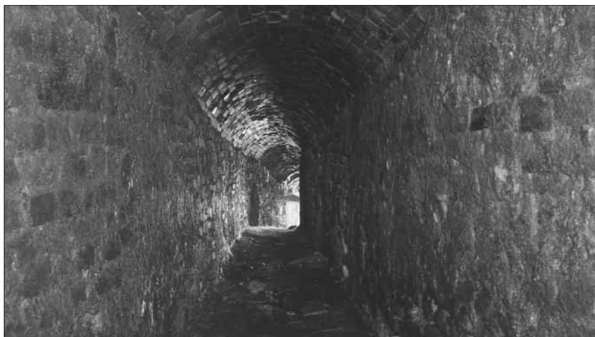
Valtice. Část zachovalého podzemí barokního komplexu.
