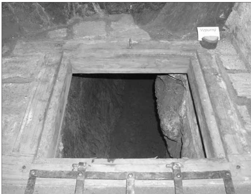
Grabštejn. Vstup do údajné únikové chodby.
